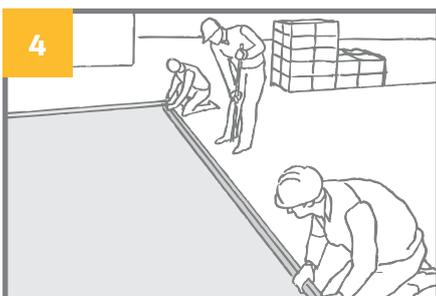
Utilizando arena limpia y seca (de granulometría 2 mm a 6 mm), se extenderá con regla, directamente sobre la base, después de construir los bordes de confinamiento. Ésta capa deberá contener 4 y 5 cm de espesor uniforme y no se empleará para crear pendientes.
