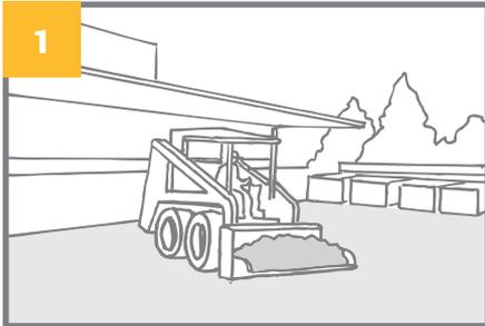
El terreno natural debe estar seco, bien drenado y compactado. Se retirarán raíces y materia orgánica hasta obtener la cota según proyecto. Se preverán las pendientes.
